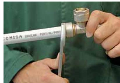
TIGHTENING THE JOINT
